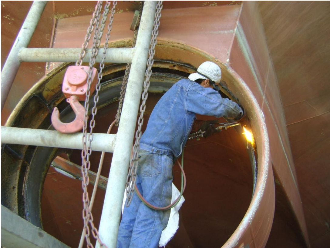
Fotografía 3. Trabajos de soldadura durante etapa de mantenimiento de la Draga Francisco de Orellana.
