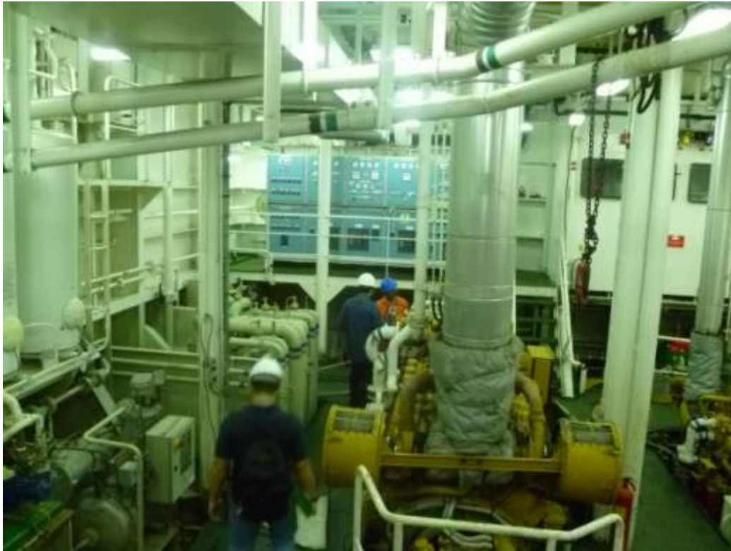
Fotografía 3. Inspección del personal de CEMA-ESPOL en el área de sala de máquinas durante etapa de mantenimiento de la Draga Francisco de Orellana.
