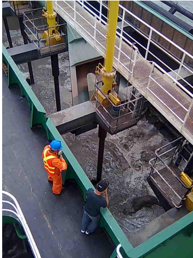
Fotografía 1. Vista del proceso de llenado de las tolvas con material dragado
